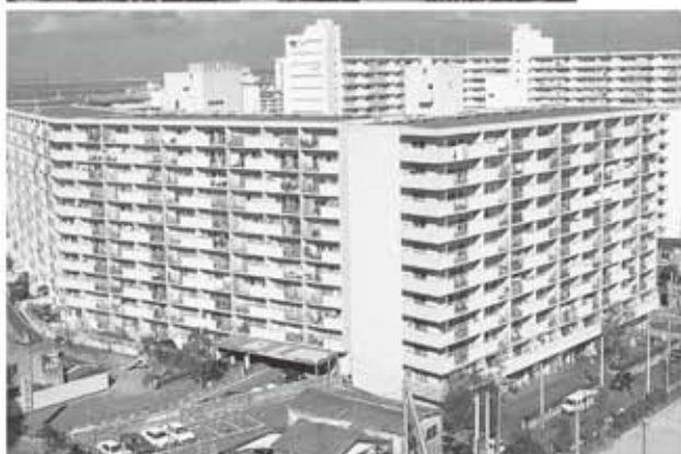
改修工事を行ったシャルマンコーポ博多（福岡市博多区千代5-1-4、1987年10月）。上の写真は改修前
